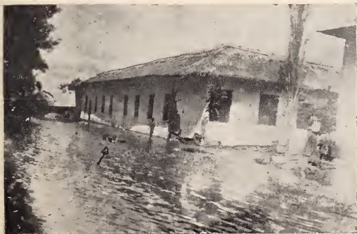
Aspecto desolador de las últimas inundaciones del Orinoco en Ara-guaimujo.
